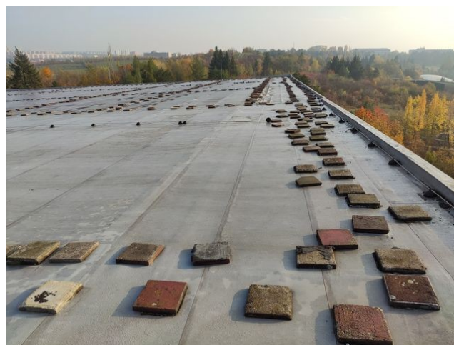
foto/3/ Pohled na plochu střechy a hydroizolační fólii
