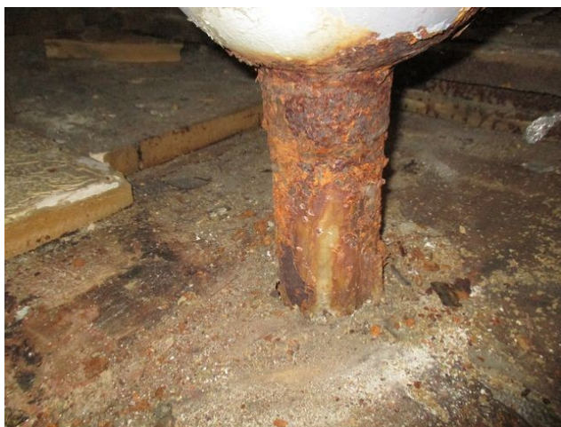
foto/36/ Pohled na dotažení asfaltového pásu k táhlu
