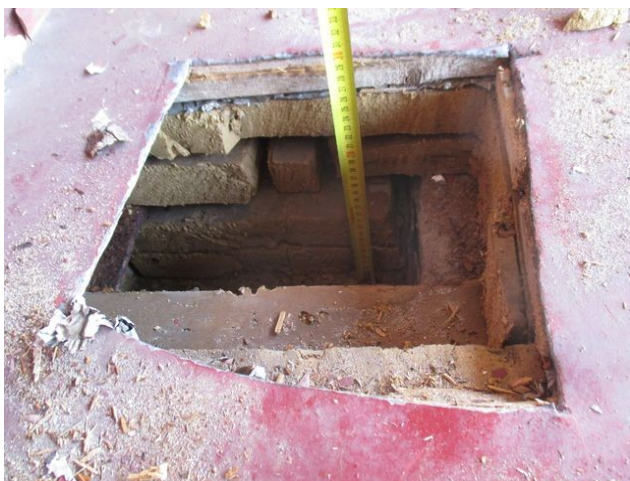
foto/30/ Pohled na provedenou sondu do západního přesahu
