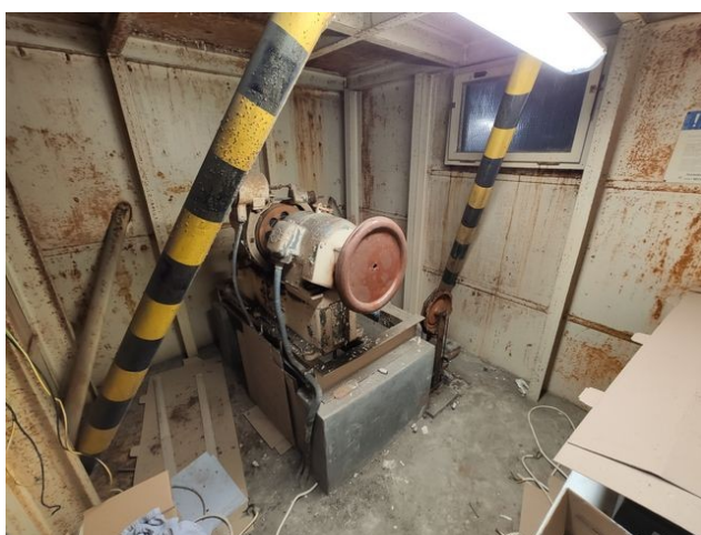
foto/24/ Pohled do strojovny výtahu a na povrchovou korozi plechového opláštění
