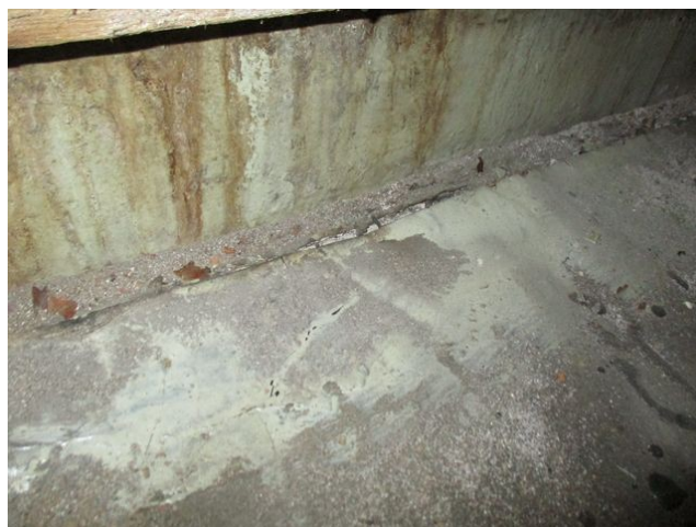
foto/37/ Pohled na ukončení asfaltového pásu u obvodového pláště
