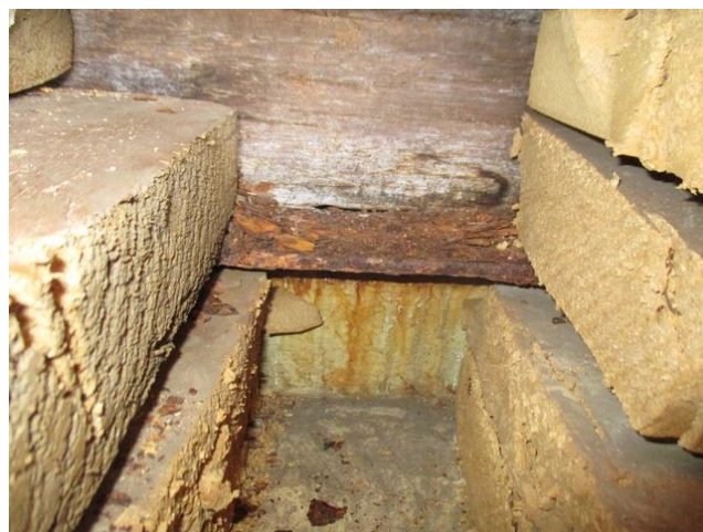
foto/31/ Pohled na provedenou sondu do západního přesahu a viditelně zkorodovaný nosný prvek
