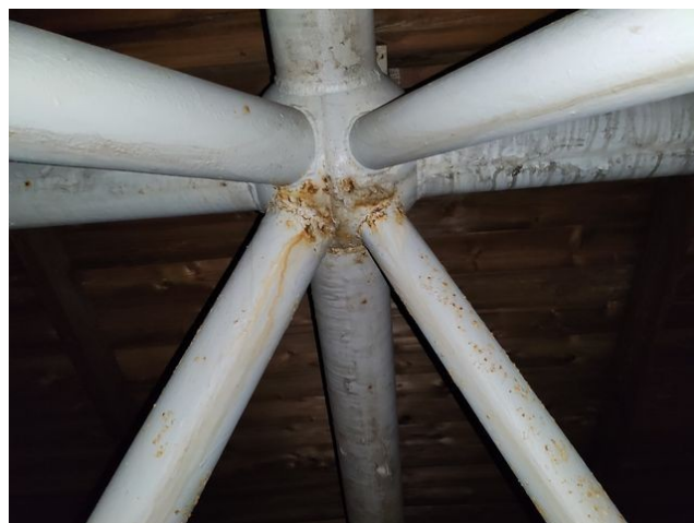
foto/23/ Pohled na nosnou konstrukci s povrchovou korozi
