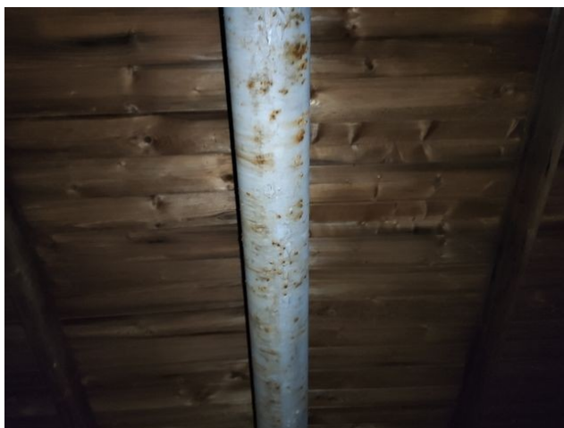
foto/22/ Pohled na nosnou konstrukci s povrchovou korozi
