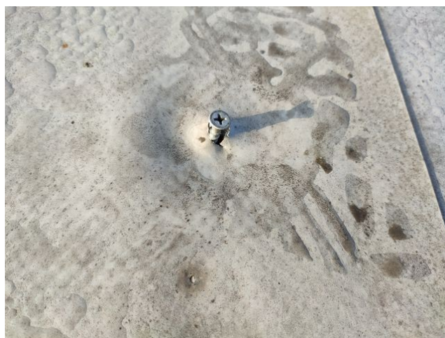
foto/9/ Pohled na netěsnost způsobenou kotevním prvkem
