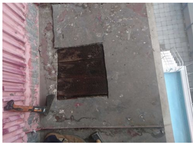
foto/33/ Pohled na provedenou sondu v jižní části přesahu a mokré dřevo uvnitř sondy
