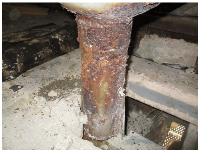
foto/39/ Pohled na zkorodovaný prvek prostupující skladbou spodního pláště
