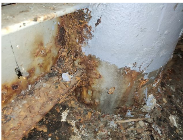
foto/40/ Pohled na zkorodovaný prvek prostupující skladbou spodního pláště
