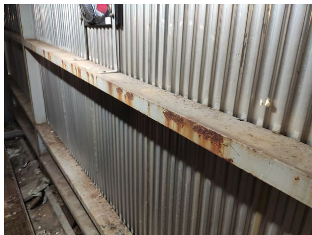
foto/21/ Pohled na konstrukce opláštění podstřešního prostoru a jejich povrchovou korozi
