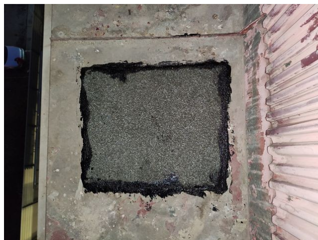
foto/35/ Pohled na zapravenou sondu v jižním přesahu
