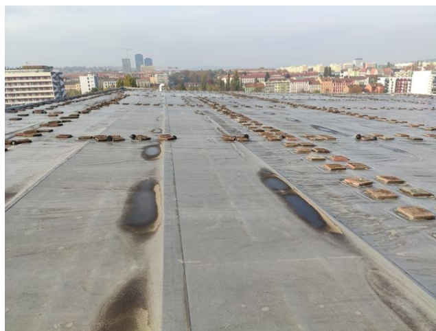
foto/7/ Pohled na kaluže v místě s prohnutými dřevěnými panely
