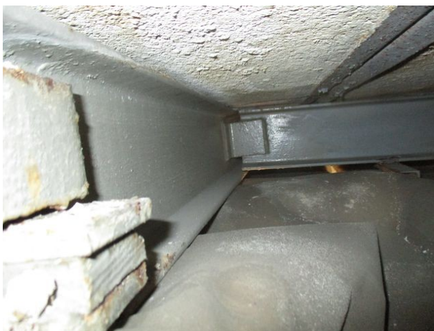
foto/42/ Pohled na ocelový nosný rám stropní konstrukce
