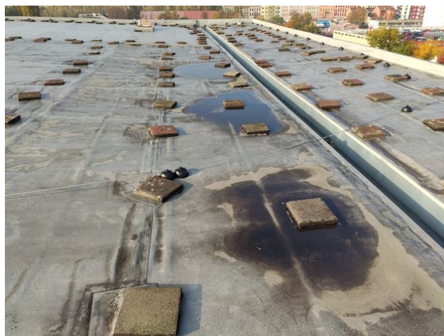
foto/5/ Pohled na kaluže v místě s prohnutými dřevěnými panely
