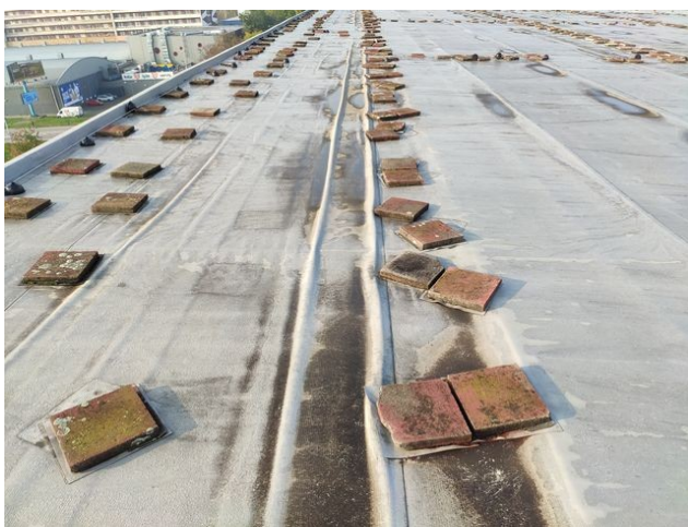
foto/8/ Pohled na zvlnění fólie
