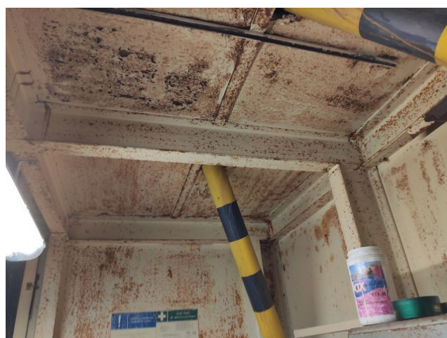
foto/25/ Pohled do strojovny výtahu a na povrchovou korozi plechového opláštění
