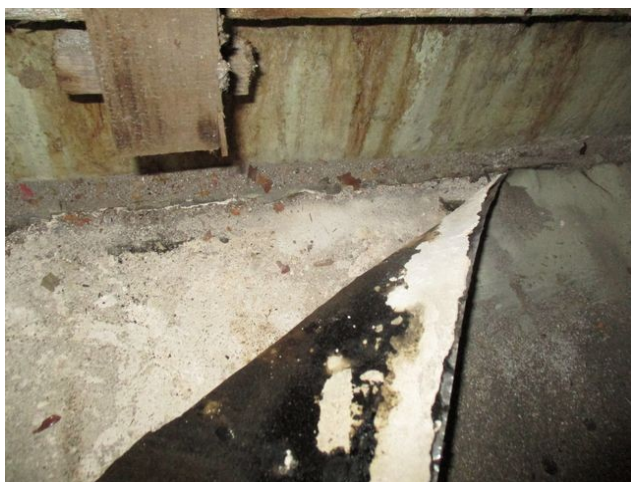
foto/38/ Pohled na ukončení asfaltového pásu u obvodového pláště
